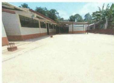
FOTO 2. TECHADO DE PATIO PRINCIPAL (PERSPECTIVA 2)
